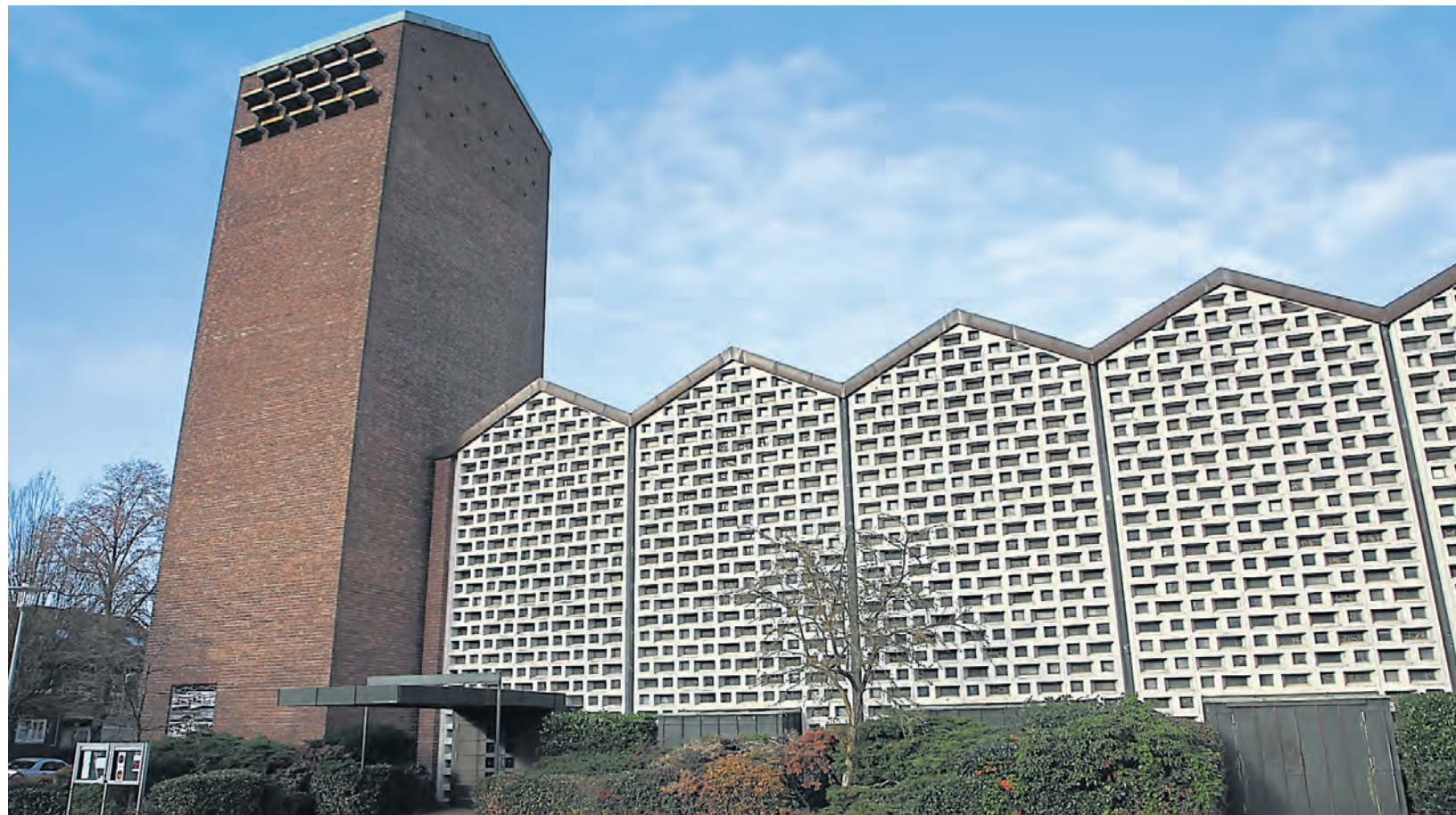
Die Herz-Jesu-Kirche könnte schon im nächsten Jahr abgerissen werden.
